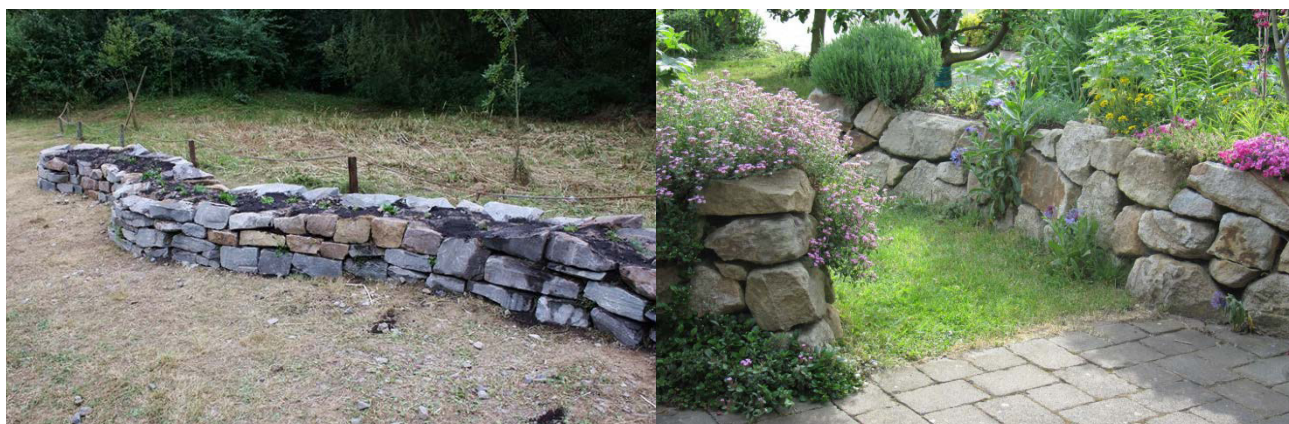
Abbildung 2: Beispiele von Trockensteinmauern. Quelle links NABU NRW; rechts Wikipedia
